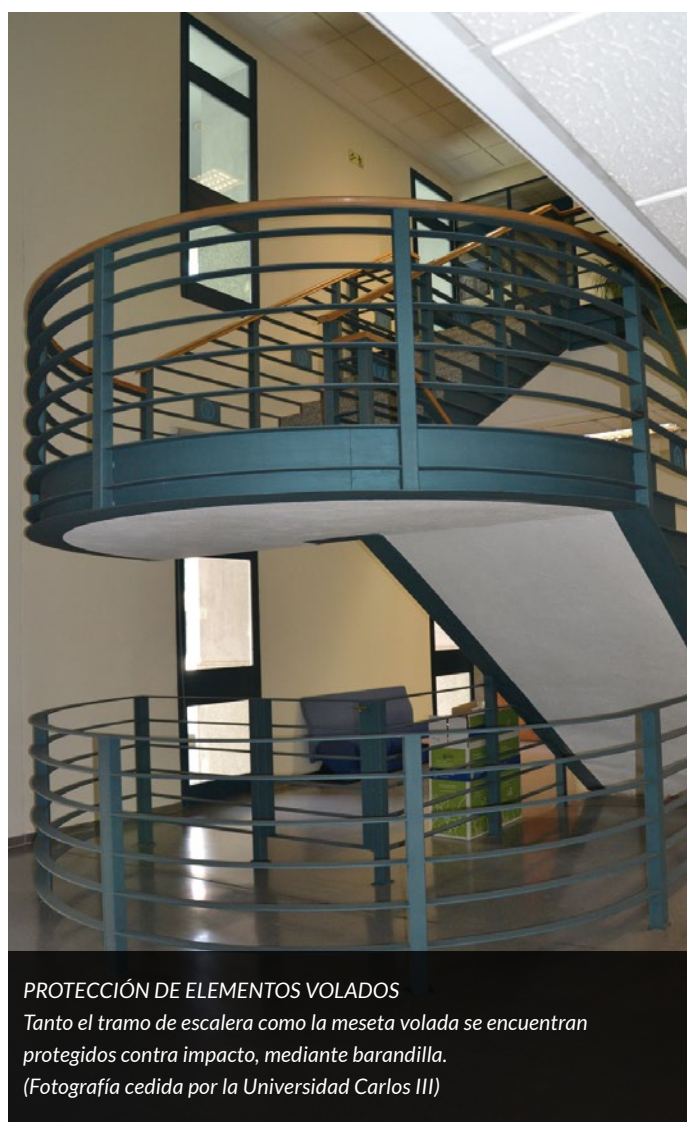
PROTECCIÓN DE ELEMENTOS VOLADOS (Fotografía cedida por la Universidad Carlos III)
