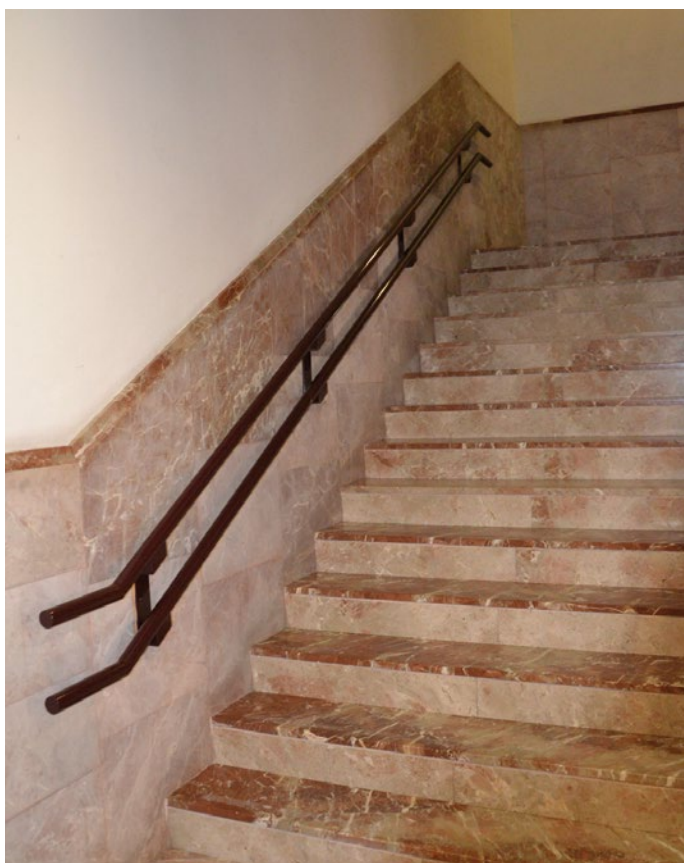
Pasamanos en paramento a dos alturas. (Fotografía cedida por la Universidad Carlos III)
