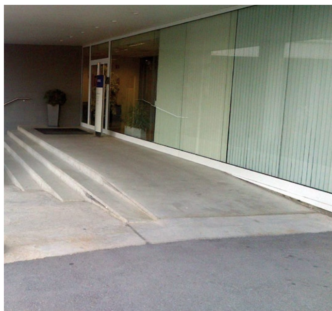
Se muestra una rampa para salvar la escalera de acceso. A destacar que el último peldaño se encuentra en rampa en su parte de conexión con la plataforma, a la que llega la rampa que va cortando los peldaños de la escalera. (Fotografía cedida por Grifols)
